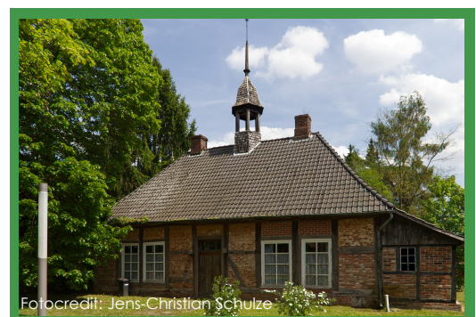
Amtsstubenhaus vor der Sanierung
